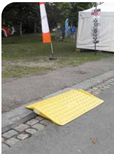
Mise en place d'une rampe pour compenser une bordure
